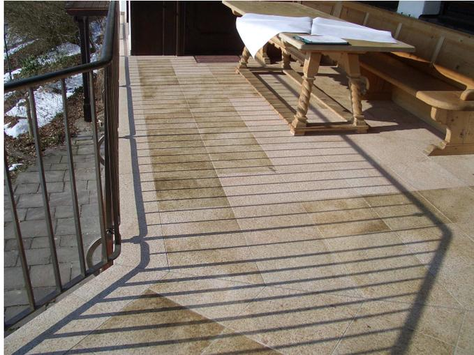
Bild 2.1.1: Ausrostungen von eisenhaltigen Mineralien
