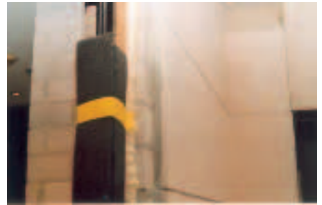
Bild 6: Angemörtelte großformatige Natursteinplatten ohne zusätzliche Verankerung in der hochwertigen Eingangslobby eines Bürogebäudes.
