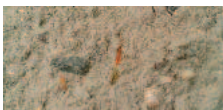
Bild 3: Organisches Material (Holzsplitter) in der obersten Schicht des Estrichs.
