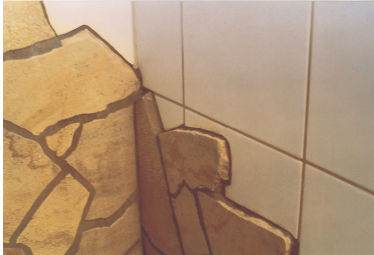
Bild 2.4.1: Rostbraun abfärbende Quarzitbekleidung
