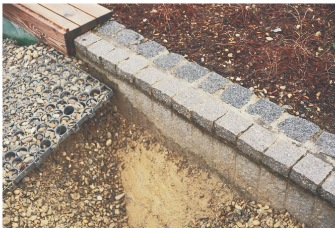
Bild 2.2.2: Teichfolie unterhalb Gefällebeton für Kiesstrand eingebaut
