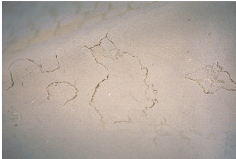
Bild 2.1.2: Stylolithen an der Oberfläche der verwendeten Kalksteine
