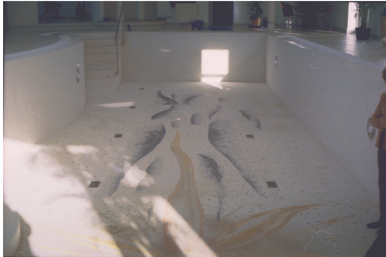
Bild 2.1.1: Schwimmbecken mit Belägen aus Kalkstein
