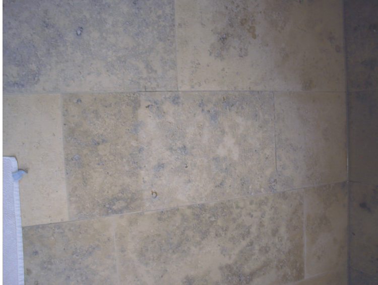
Bild 2.3.2: Durch Bleichen teilweise entfärbte Kalksteine
